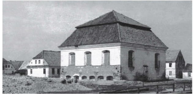
Abb. 38 Blick von Süd-Osten 1953
