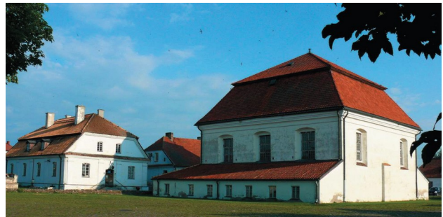
Abb. 40 Blick von Süd-Osten 2015
