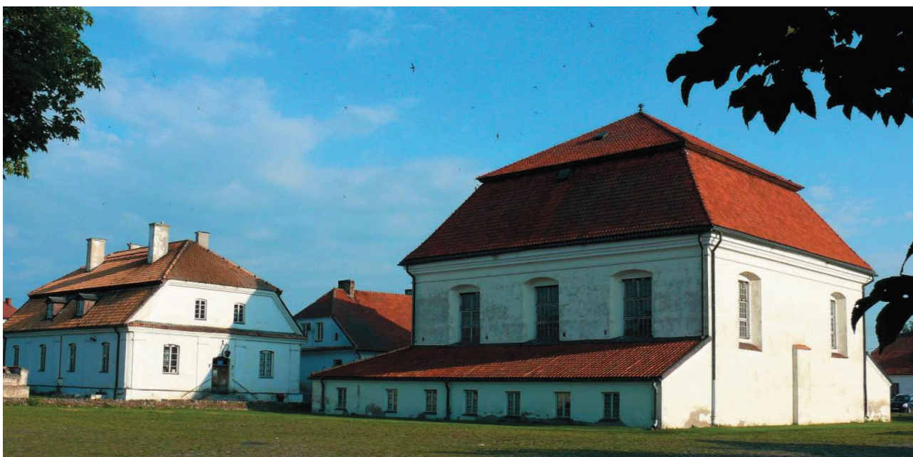
Abb. 40 Blick von Süd-Osten 2015
