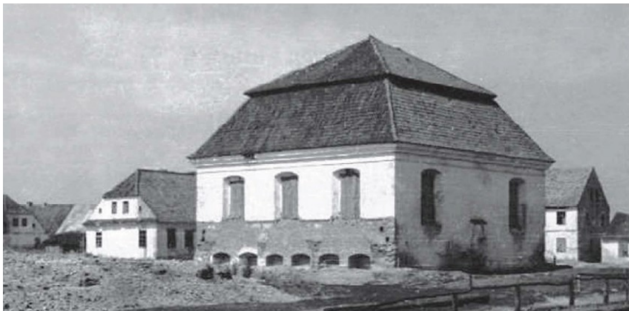
Abb. 38 Blick von Süd-Osten 1953
