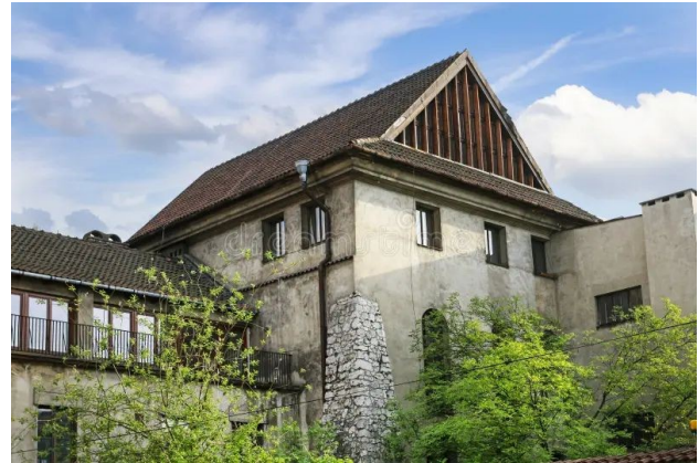
Abb. 72 Ansicht von Nordosten, 2018
