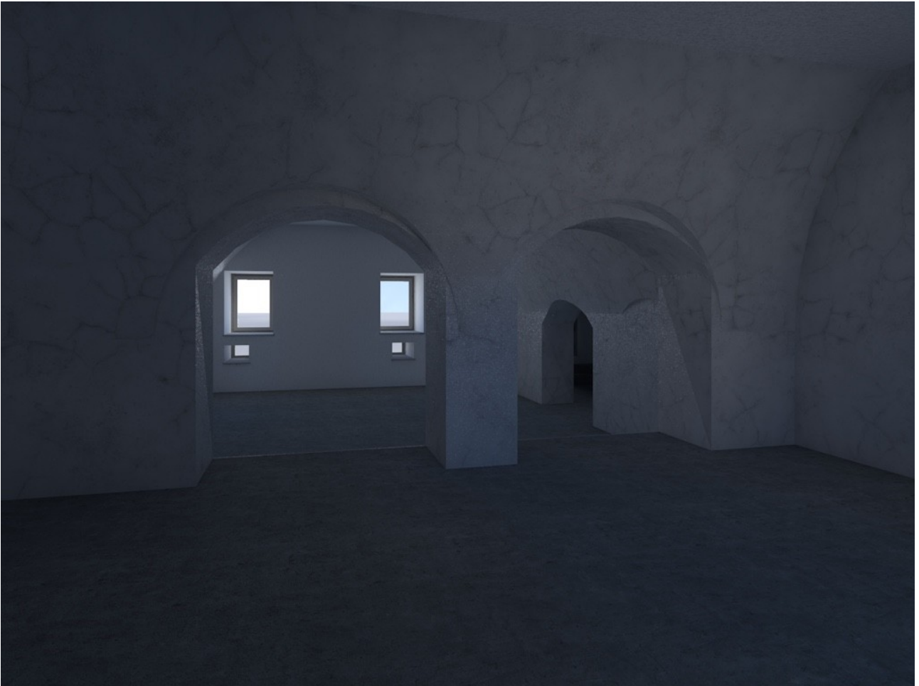
Abb. 115 Gewölbe im EG 1961
