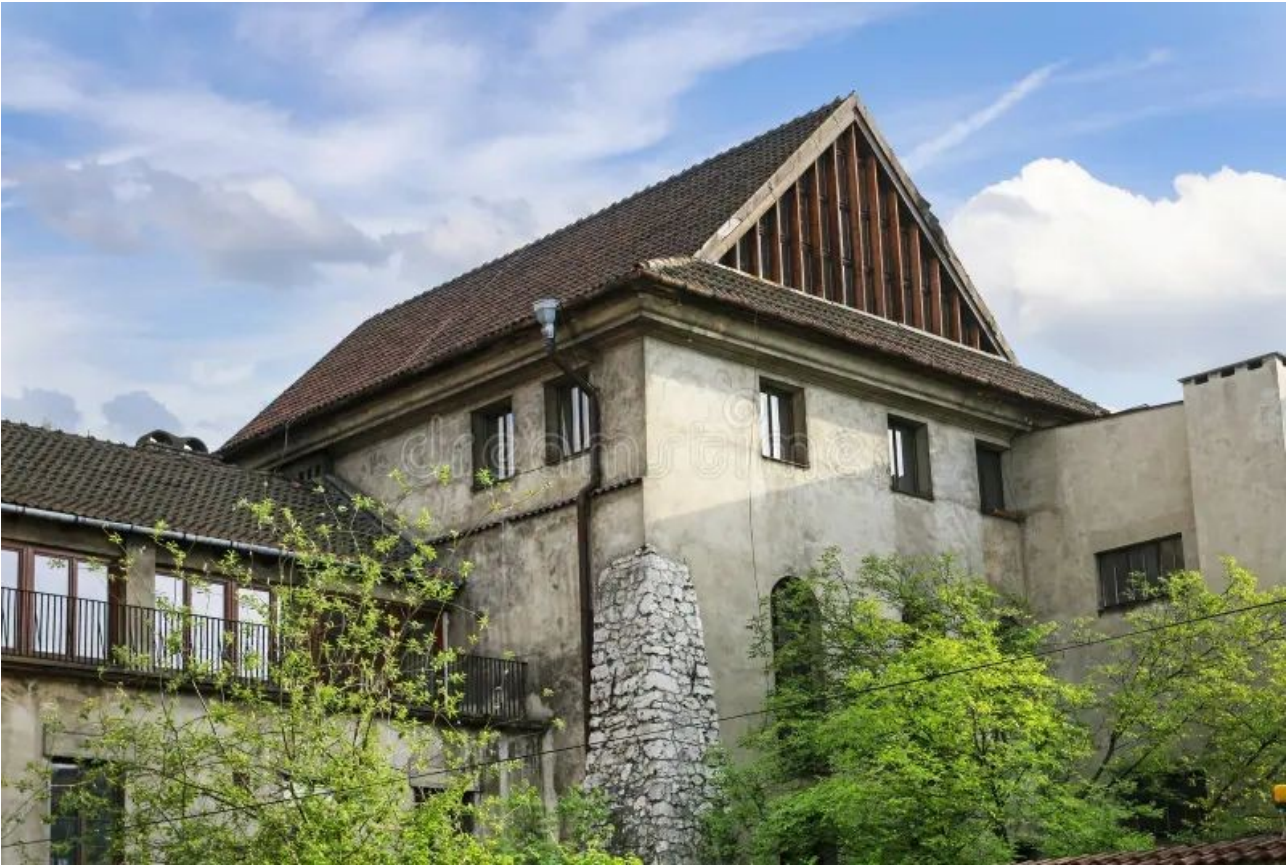
Abb. 72 Ansicht von Nordosten, 2018
