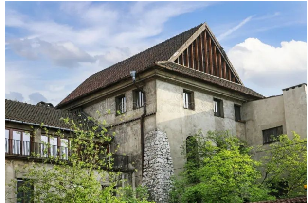
Abb. 72 Ansicht von Nordosten, 2018
