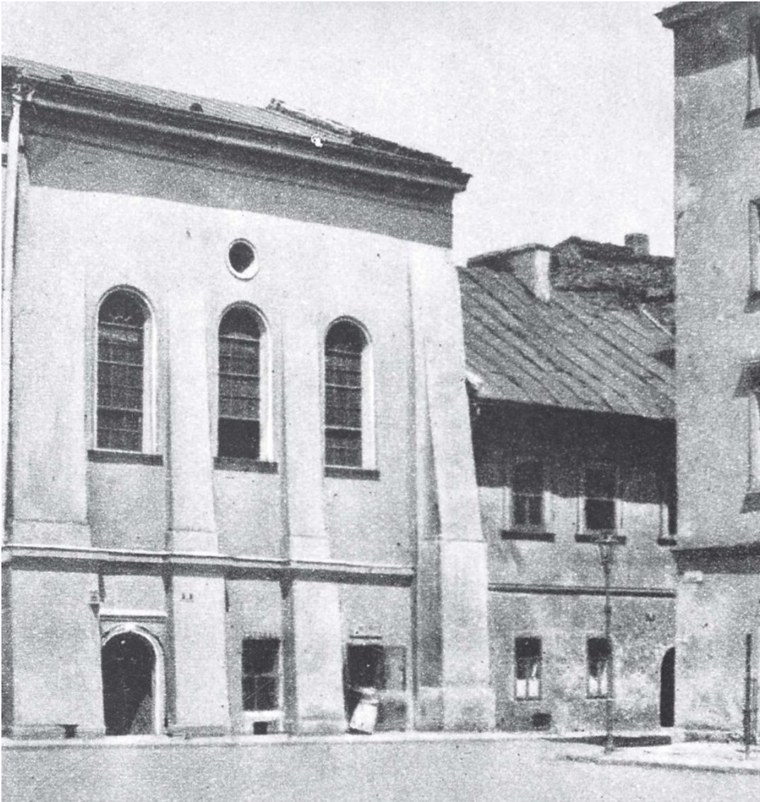
Abb. 66 Ansicht von Süden, 1935
