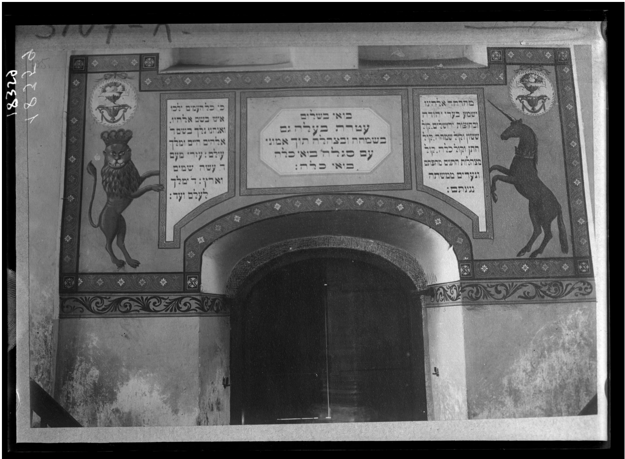
Abb. 17 Hauptportal aus Richtung des Gebetsraums
