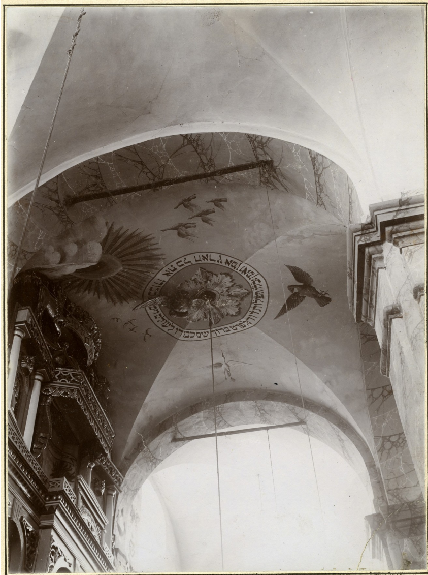
Abb. 10 Gewölbe oberhalb des Torahschreins
