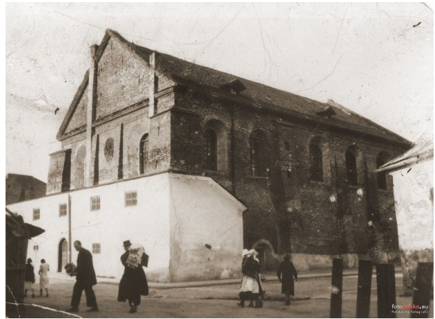
Abb. 9 Ansicht Südwest, August 1937
