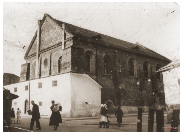
Abb. 9 Ansicht Südwest, August 1937
