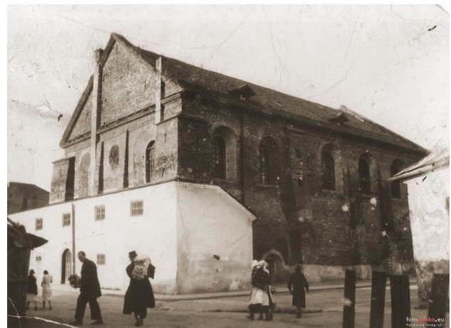
Abb. 9 Ansicht Südwest, August 1937
