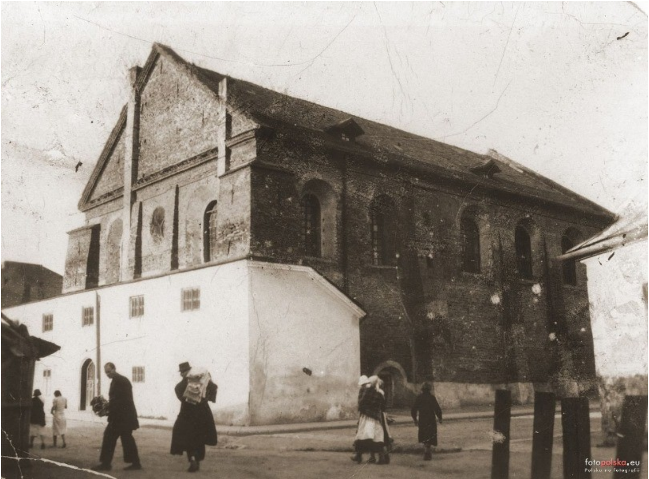
Abb. 9 Ansicht Südwest, August 1937
