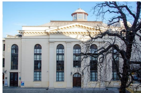
Abb. 17 Foto Ansicht Süd-West
