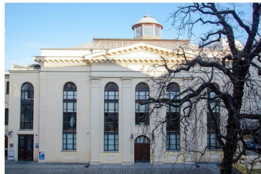
Abb. 17 Foto Ansicht Süd-West
