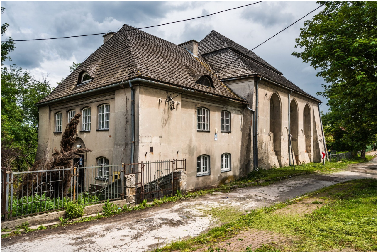
Abb. 7 Ansicht von Südosten
