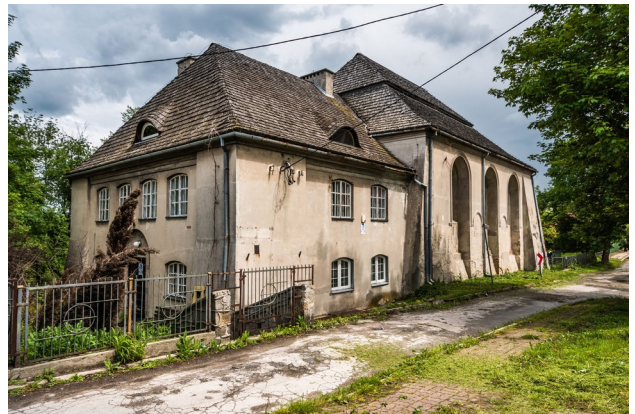
Abb. 7 Ansicht von Südosten
